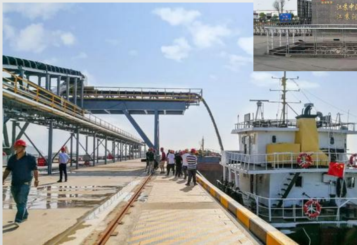
江苏润华物流定量装船皮带秤现场
