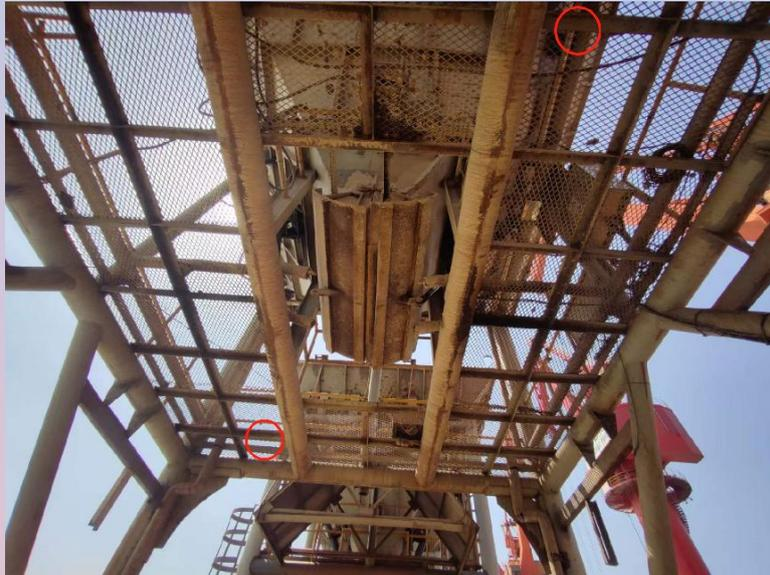
图片 10：雷达尽量远离放料口安装
